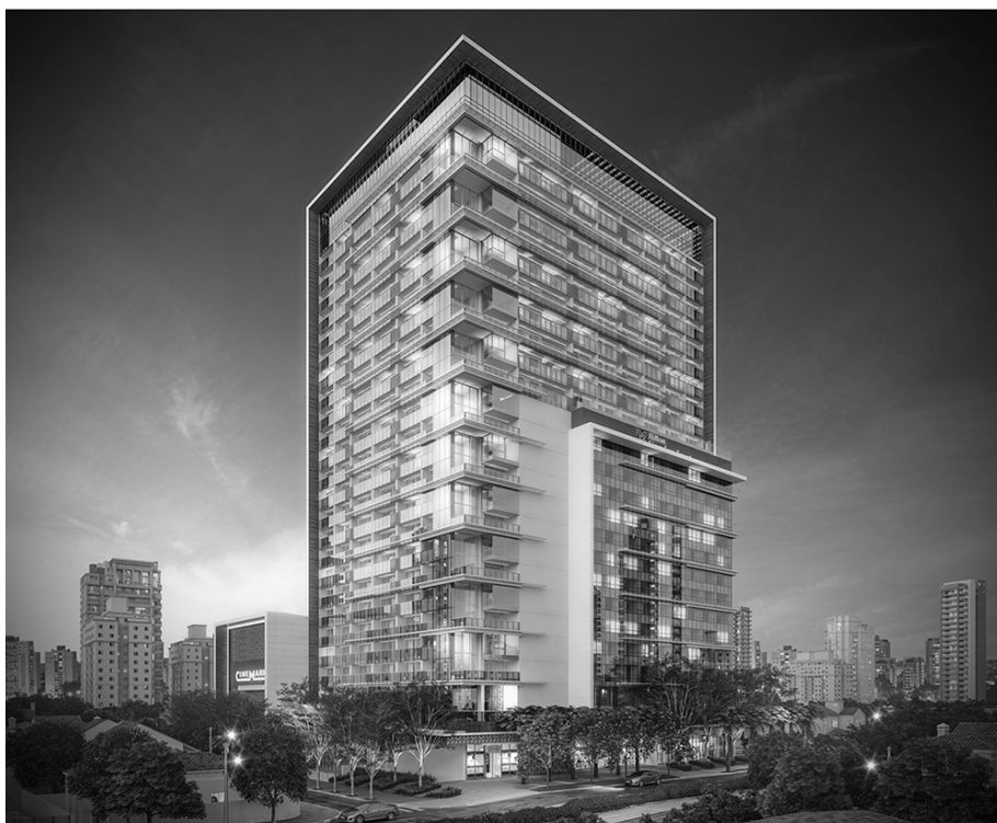
Figura 7. Fachada ativa do Edifício Helbor Wide São Paulo. Avenida Rebouças, 2636 – Pinheiros – São Paulo – SP
